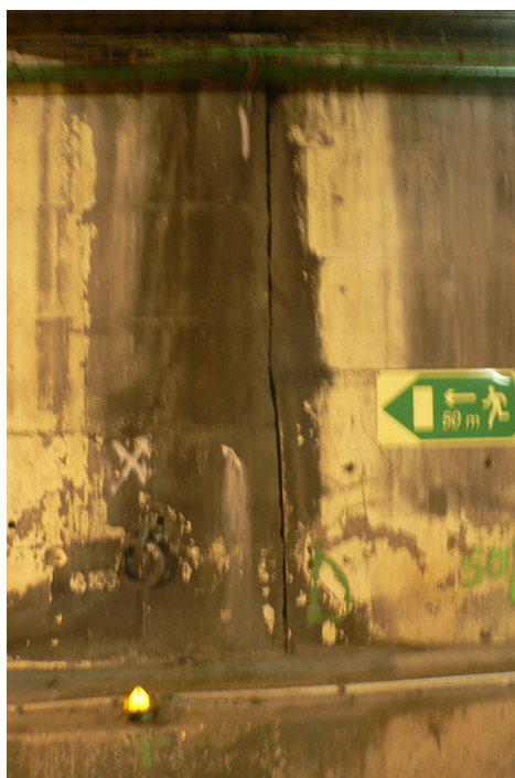
Illustration 29 Trace d'une infiltration d'eau à la jonction de deux plots béton.
