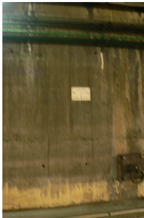
Illustration 28 Traces et phénomènes d'infiltration en tête de piedroit.
