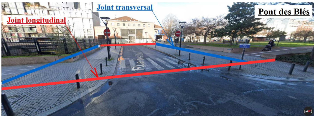
Illustration 14: Localisation schématique des différents joints de chaussée du Pont des Blés
