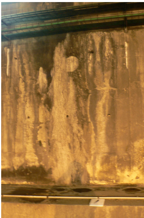
Illustration 27 Traces de ruissellement causées par des venues d'eau au niveau des franchissements.
