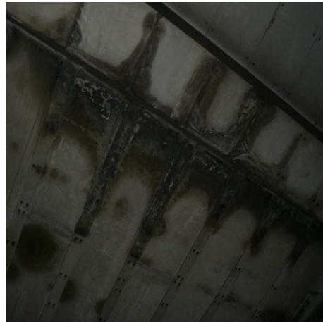
Illustration 34 Traces d'eau en plafond au niveau des joints transversaux.
