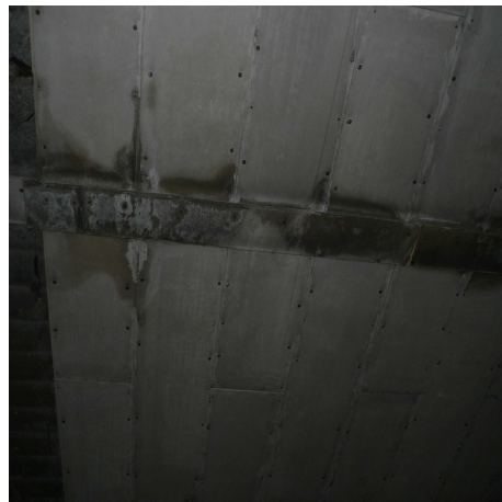
Illustration 36 Venues d'eau au plafond dues à des infiltrations au niveau des joints de franchissements.
