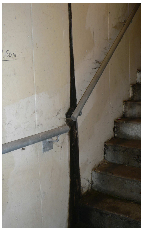
Illustration 31 Traces d'eau significatives au niveau de l'escalier d'une issue de secours.
